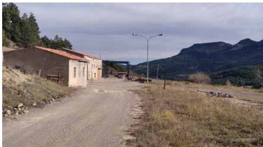
Equipaments on s'ubicaran les plaques fotovoltaïques, a teulada i al sòl. Font: Ignasi Ripoll
