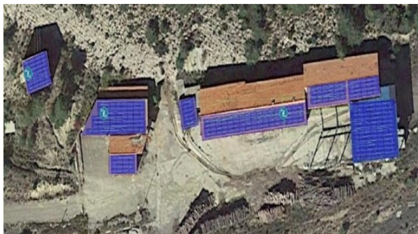
Mostra de la ubicació de les plaques fotovoltaïques a teulada. Font: Ignasi Ripoll
